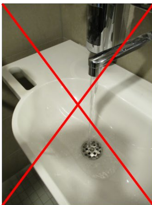
Abbildung 12: Negativbeispiel für die Kombination Armatur-Abfluss
