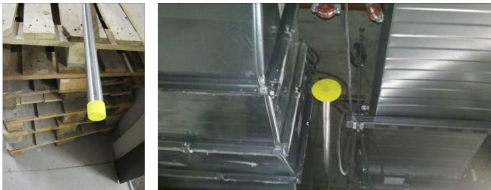
Abbildung 18: Beispiel für den Verschluss montierter Rohrleitungen
