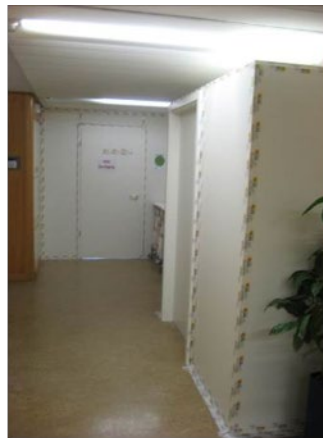
Abbildung 26: Positivbeispiele fest installierte Staubschutzwände
