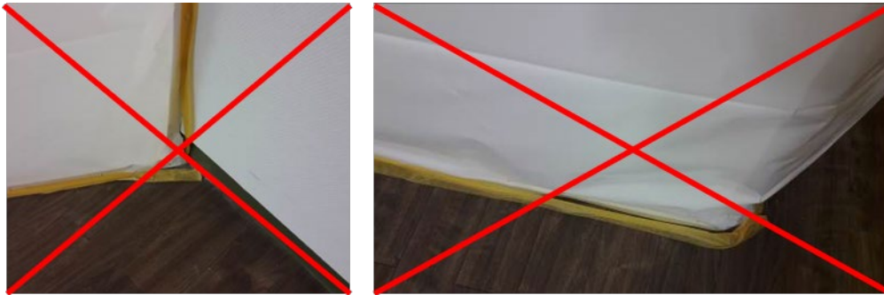
Abbildung 25: unzureichend abgeklebte Staubschutzfolie
