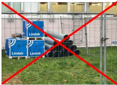
Abbildung 20: Negativbeispiel für die Lagerung von Lüftungsleitungen
