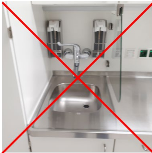
Abbildung 14: Negativbeispiel für die Montage von Spendern und Armatur
