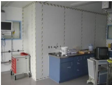
Abbildung 26: Positivbeispiele fest installierte Staubschutzwände
