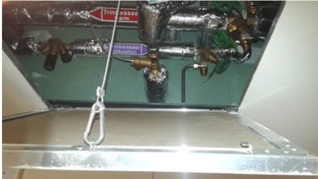
Abbildung 19: Negativbeispiel für den Einbau von Probennahmeventilen
